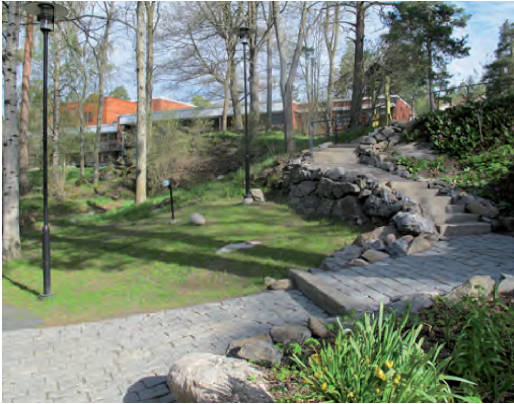
Sisääntulopihalle johtavat Villa Varalan portaat on pengerretty kivillä.
