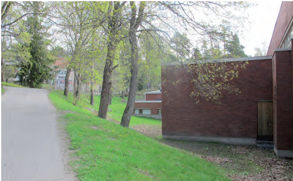
Päärakennuksen liitos ympäröivään rakennettuun maisemaan on sulautuva. Näkymä pohjoisen huoltotien suunnasta.
