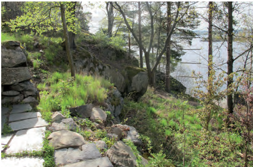
Villa Varalan itäpäädyn rinteeseen otettiin esiin vanhat kiviporrasladelat restaurointiyön yhteydessä vuonna 2011.
