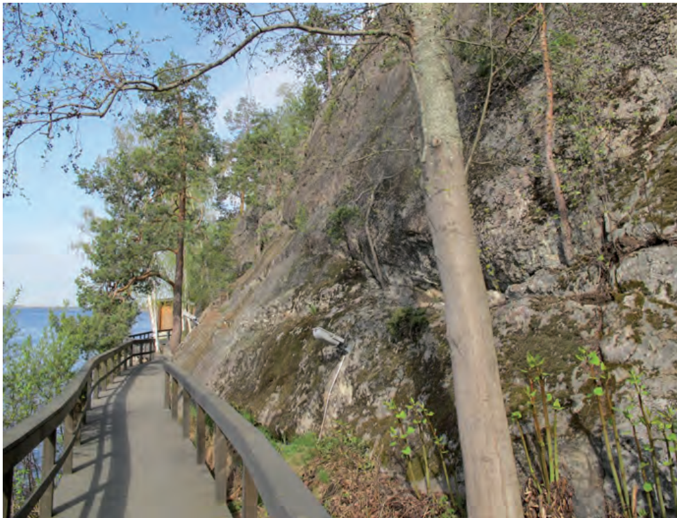
Rantasaunalta hirsisaunalle johtava puusilta.
