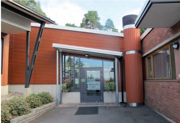
Vanhan osan ja uuden laajennuksen liitoksessa on pintaverhoiluina käytetty profiilipeltiä.
