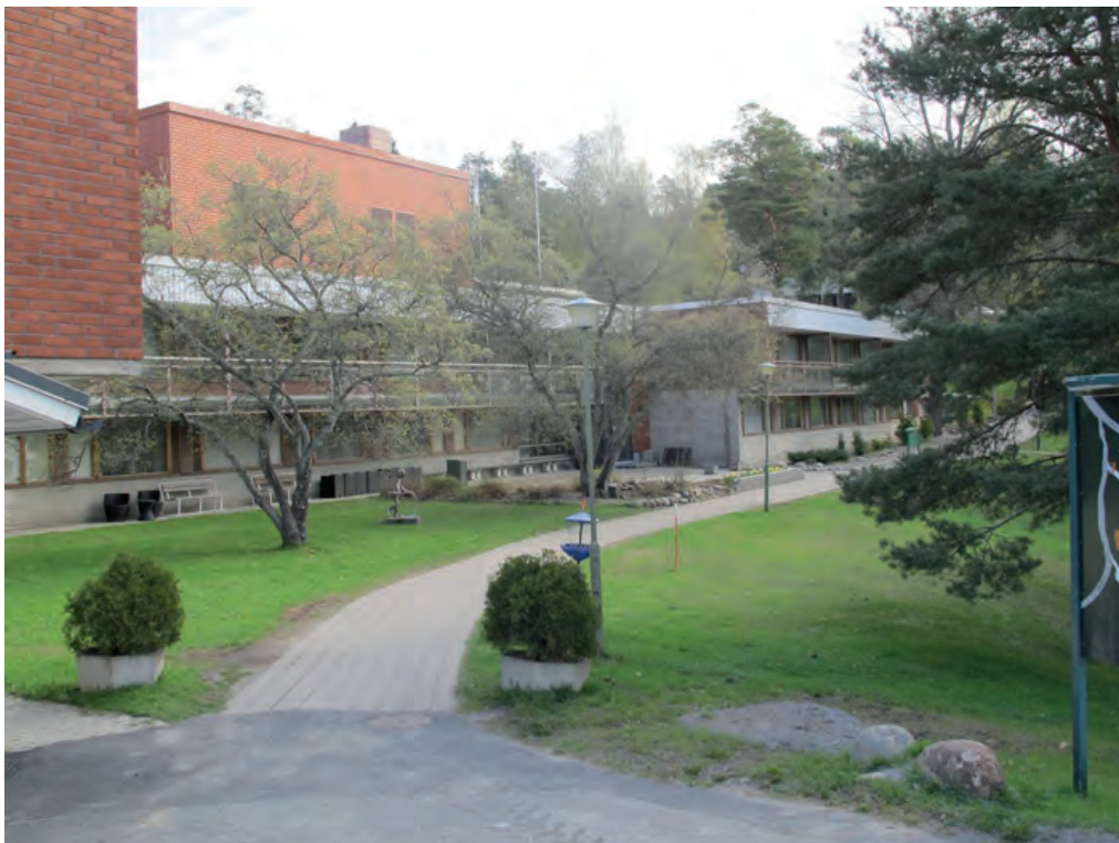
Päärakennus Majalan pihalta katsottuna.
