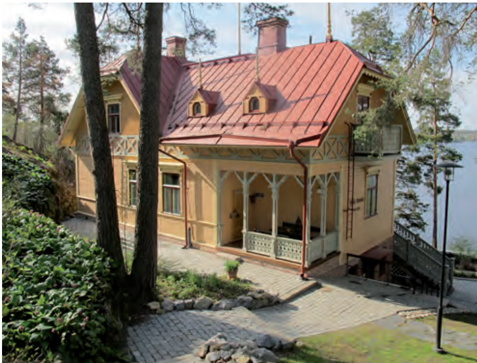
Restauroitu huvila v. 2012. Vesikatolle palautettiin Karl Snellmanin alkuperäisten piirustusten mukaiset puusalot ja päätyterassi purettiin. Julkisivuvärit palautettiin alkuperäisiksi.
