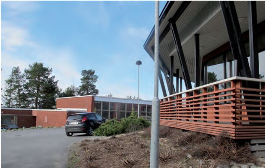
Majala sijaitsee ravintola Säteen eteläpuolella.
