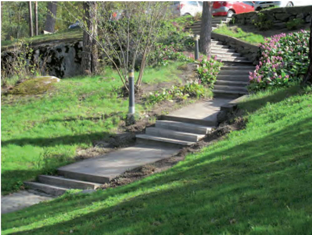
Kalliolaan johtavat betoniportaavat on upotettu rinteeseen.
